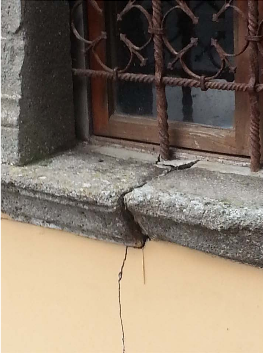
Rottura del davanzale
